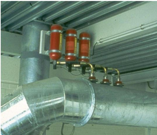
**Abb.3.368:** Löschmittelsperre für Aspirationsleitung
