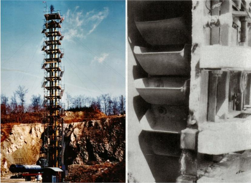
**Abb.3.370:** Gesamtansicht des verstärkten Gurtelevators (links) und des Becherwerkes (rechts)
